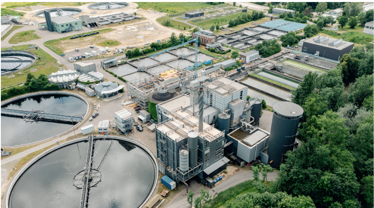
Abb. 1: Luftaufnahme des Klärwerks Steinhäule und der thermischen Klärschlammverwertung
